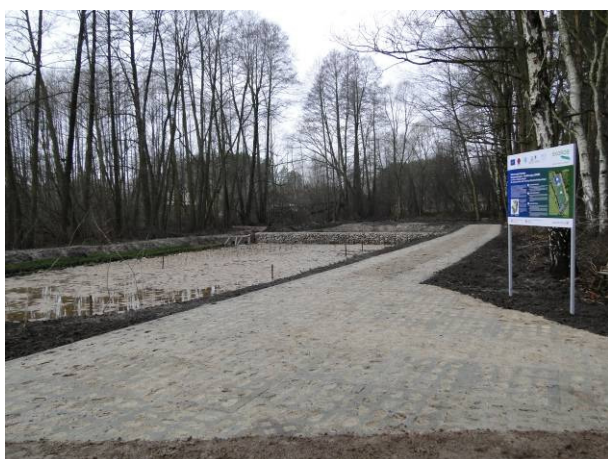
Fot. (a) Widok na strefę biofiltracji: przygotowane podłoże piaskowe do nasadzeń oraz droga technologiczna ułatwiająca konserwację SSSB. (b.) przepust odprowadzający wodę z sekwencyjnego systemu wraz z bystrotokiem wyłożonym dolomitem, poligon demonstracyjny Swolszewice, jesień 2015
