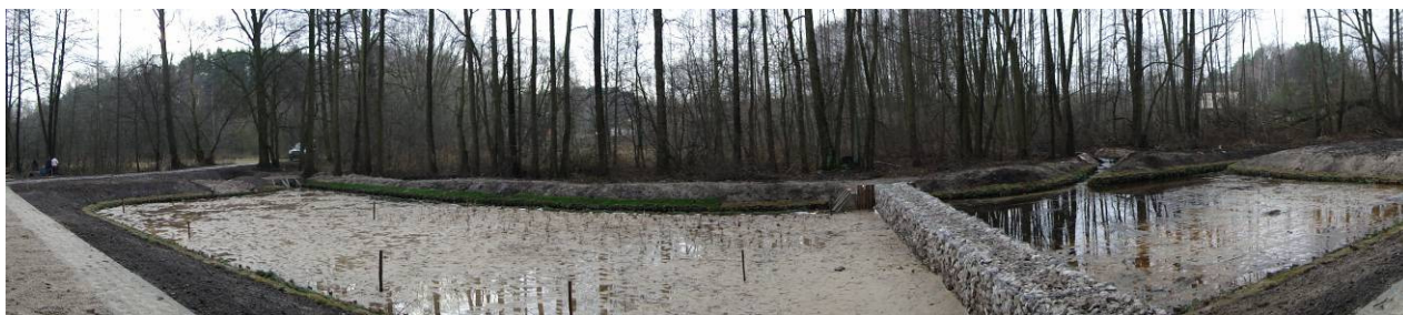
Fot. Sekwencyjny system sedymentacyjno-biofiltracyjnego dla doczyszczania wód Dopływu z Goleszy Dużych, jesień 2015
