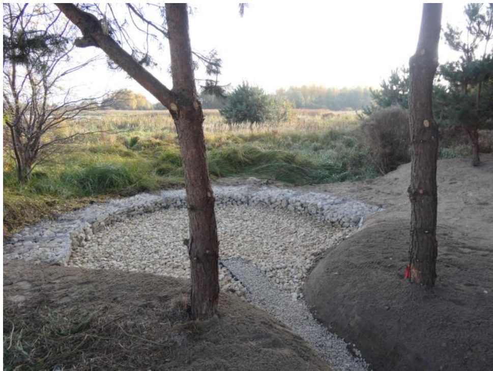
Fot. Niecka i przegroda gabionowa wyłożone kamieniem wapienno-dolomitowym, w tle strefa biofiltracyjnej, poligon demonstracyjny Barkowice Łąka
