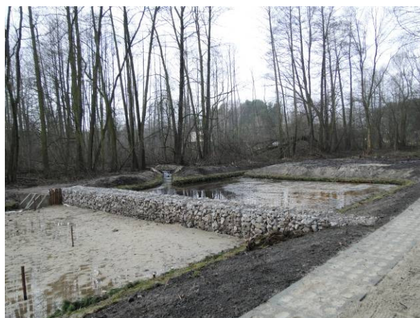
Fot. (a) Ujście cieków zasilających SSSB do strefy sedymentacji. (b.) widok na strefę geochemiczną składającą się z gabionów wypełnionych dolomitem oraz głębiej strefa sedymentacji, poligon demonstracyjny Swolszewice, jesień 2015
