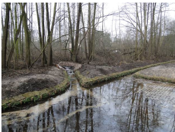
Fot. (a) Ujście cieków zasilających SSSB do strefy sedymentacji. (b.) widok na strefę geochemiczną składającą się z gabionów wypełnionych dolomitem oraz głębiej strefa sedymentacji, poligon demonstracyjny Swolszewice, jesień 2015
