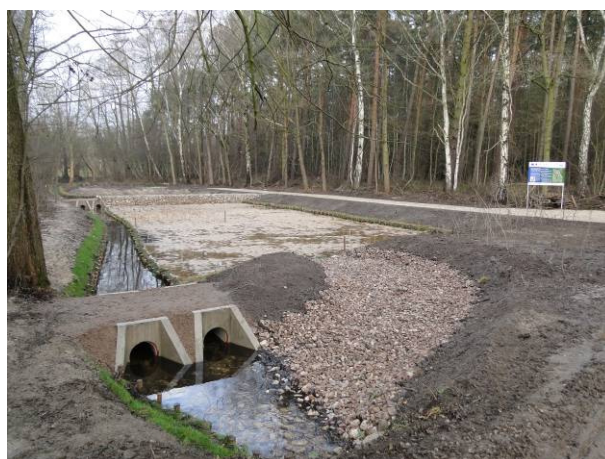
Fot. (a) Widok na strefę biofiltracji: przygotowane podłoże piaskowe do nasadzeń oraz droga technologiczna ułatwiająca konserwację SSSB. (b.) przepust odprowadzający wodę z sekwencyjnego systemu wraz z bystrotokiem wyłożonym dolomitem, poligon demonstracyjny Swolszewice, jesień 2015
