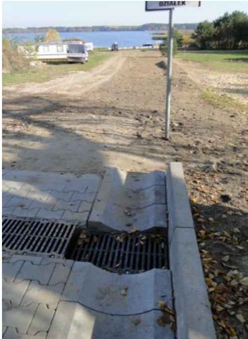
Fot. (a) Ujęcie wód opadowych poprzez kratkę z wbudowaną w dnie studzienką sedymentacyjną, dalej odcinek podziemny systemu (b) wylot oraz rów infiltracyjny, poligon demonstracyjny Barkowice Łąka
