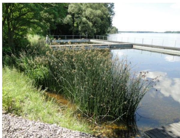
Fot. Roślinna strefa ekotonowa nasadzona wzdłuż linii brzegowej, przed roślinami od strony zbiornika pod wodą znajduje się bariera biogeochemiczna na bazie wapienia, poligon demonstracyjny Zarzęcin, lato 2014
