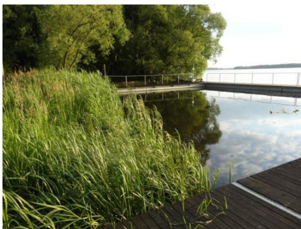
Fot. Roślinna strefa ekotonowa nasadzona wzdłuż linii brzegowej, przed roślinami od strony zbiornika pod wodą znajduje się bariera biogeochemiczna na bazie wapienia, poligon demonstracyjny Zarzęcin, lato 2014
