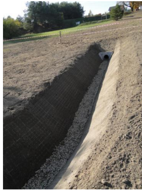
Fot. (a) Ujęcie wód opadowych poprzez kratkę z wbudowaną w dnie studzienką sedymentacyjną, dalej odcinek podziemny systemu (b) wylot oraz rów infiltracyjny, poligon demonstracyjny Barkowice Łąka
